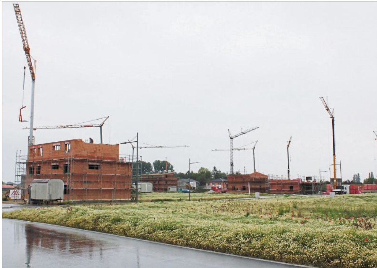
Im Stutzwinkel wird bereits emsig gebaut. Das dort vorgesehene Projekt Mehrgenerationenwohnen hat durch die Coronakrise allerdings einen Dämpfer erfahren. Vom ehrgeizigen Ziel eines Baubeginns noch heuer mussten sich die Akteure verabschieden. Fotos: Monika Schneider-Stranninger
